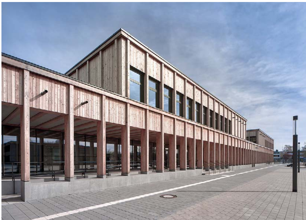
Fassadenansicht der IGS Rinteln
