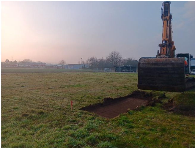
Abbildung 1: Baggersondagen in Landesbergen
