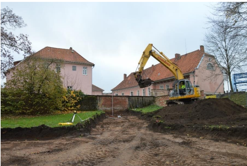
Abb. 7 Hoya FStNr. 6, Gde. Stadt Hoya, Ldkr. Nienburg (Weser). Bodenabtrag für die geplante Schlosszufahrt, die im Bereich einer neuzeitlichen „Ziegelplombe“ in der über 2,00m hoch erhaltenen historischen Mauer angelegt ist. Foto: D. Rathert.
