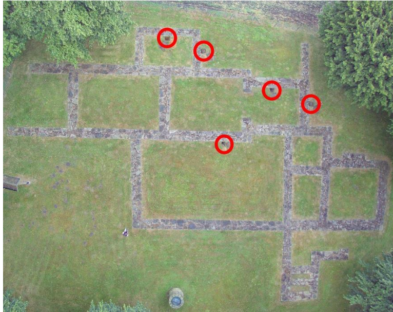
Abb. 37 Rehburg FStNr. 17, Gde. Stadt Rehburg-Loccum, Ldkr. Nienburg (Weser). Lage der Sondagen im Luftbild der ergrabenen und rekonstruierten Mauerverläufe. (Foto/Grafik: R. Reimann, J. Berthold)
