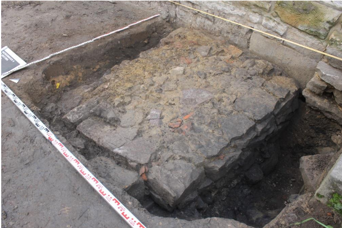
Abb. 57 Sachsenhagen FStNr. 9, Gde. Stadt Sachsenhagen, Ldkr. Schaumburg. Freigelegtes Fundament auf dem Burghügel von Sachsenhagen. (Foto: J. Berthold)
